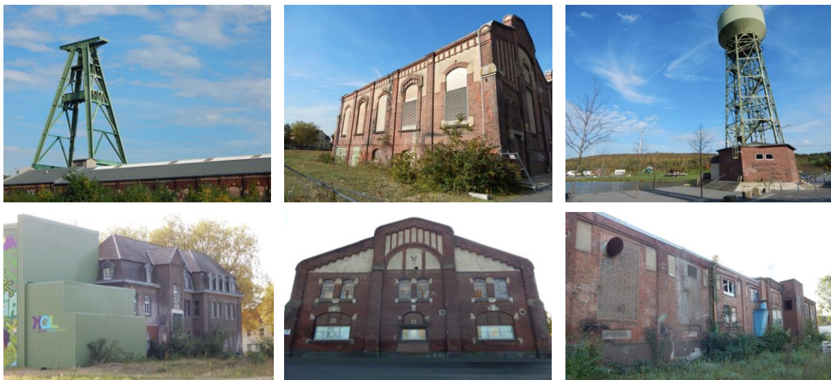
Foto 1: Fördergerüst Schacht 2, Foto 2: Fördermaschinenhaus, Foto 3: Wasserturm, Foto 4: Verwaltungsgebäude, Foto 5: Zechenwerkstatt, Foto 6: Zentralmaschinenhaus, Quelle: Stadt Dinslaken
