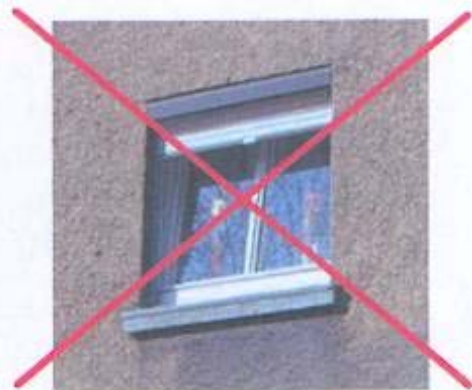
Nicht mögliche Rollladenanordnung, da die Fensteröffnung verkleinert wird.
