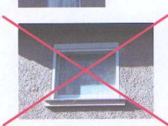
Nicht mögliche Rollladenanordnung, da die Fensteröffnung verkleinert wird.
