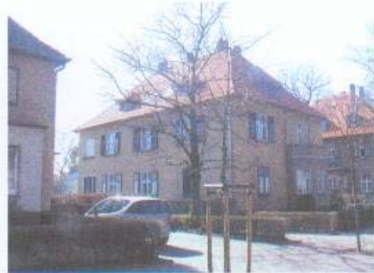
Offene Bebauung an der Kasinostraße
