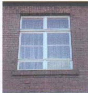
Originale oder dem Original nachempfundene Flügel- und Scheibengliederung
