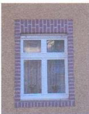
Originale Fensterbänke, ausgeführt als Ziegelrollschicht bzw. in Stein/Putz
