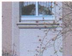
Originale Fensterbänke, ausgeführt als Ziegelrollschicht bzw. in Stein/Putz
