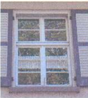
Originale oder dem Original nachempfundene Flügel- und Scheibengliederung
