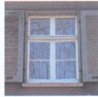
Originale oder dem Original nachempfundene Flügel- und Scheibengliederung
